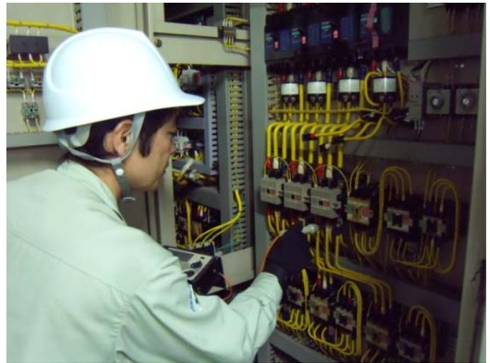
冷水ポンプ点検・動力盤内での
