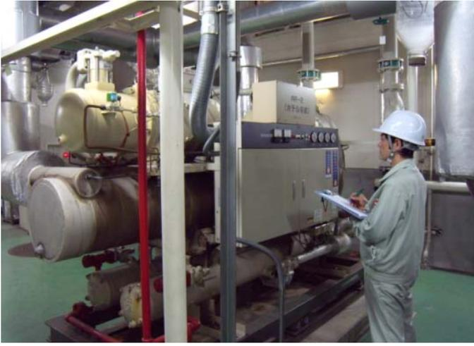
地下機械室内設置のチラー冷凍機
