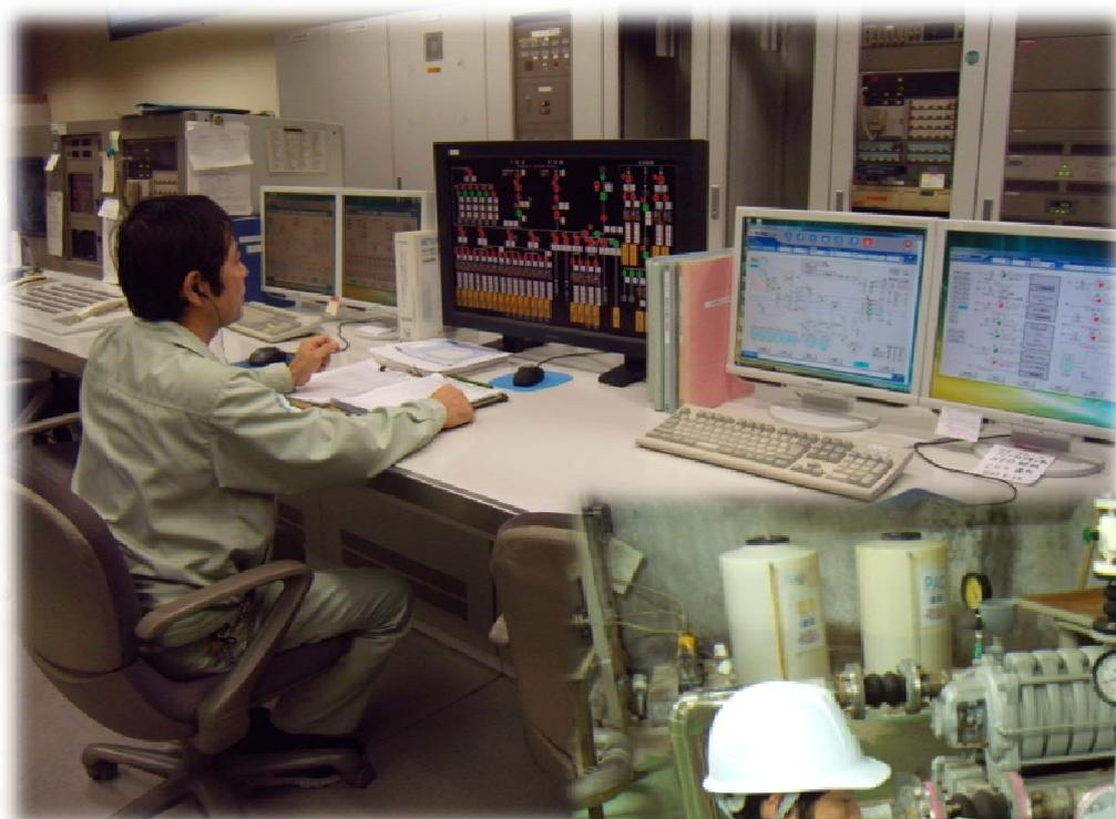
防災センター内中央監視装置での機器運転監視
