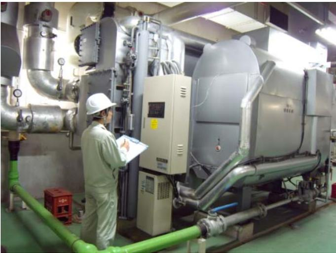
地下ボイラー室内設置の吸収式
